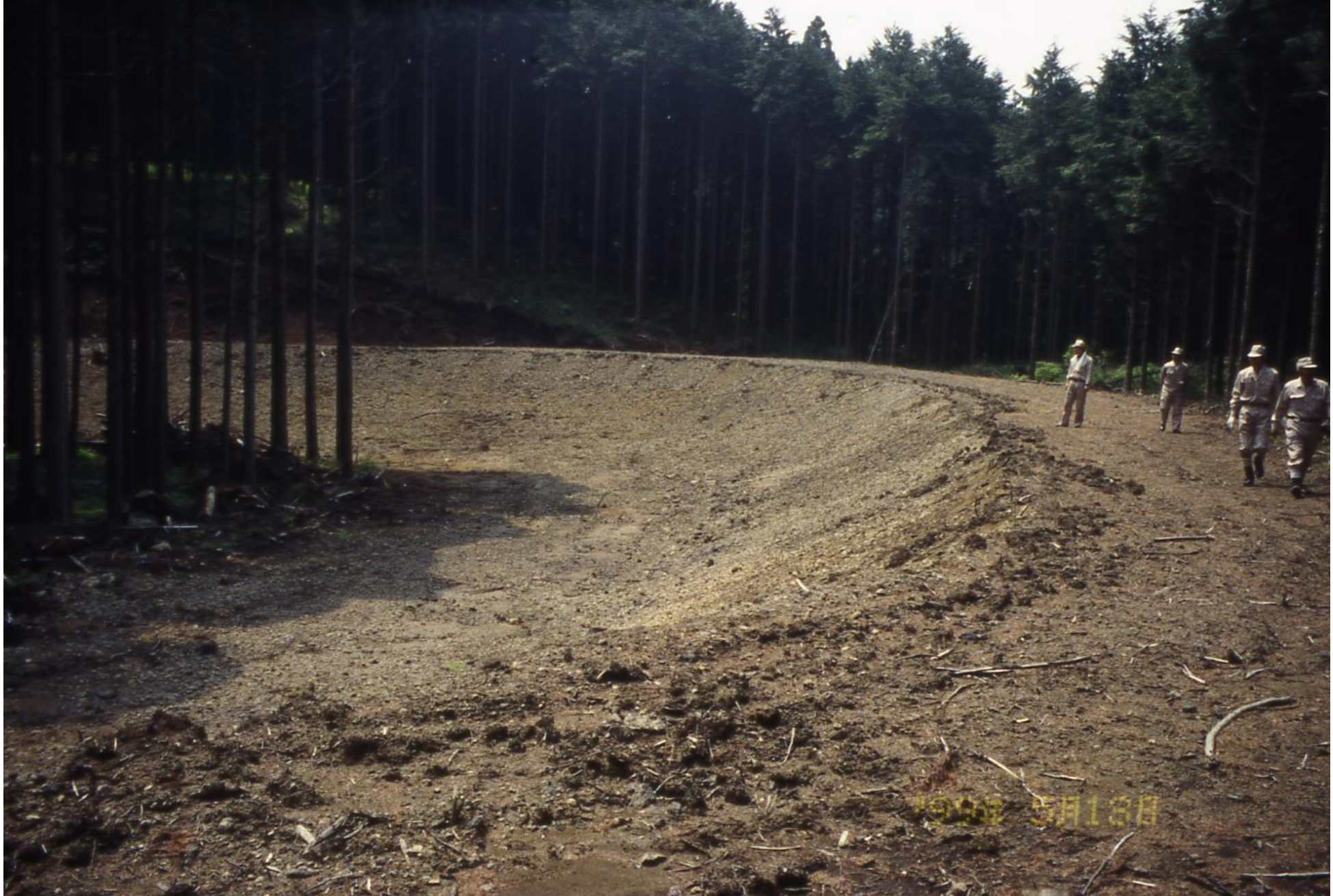
富士市大淵に作設した作業道 兼 空ダム 4万トン貯留
