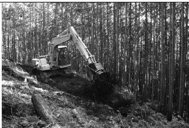
防災水源涵養路の作設 建設費は間伐・支障木収入
