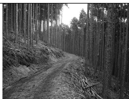
富士宮市山宮 無間伐林に作設した防災水源涵養路 18
