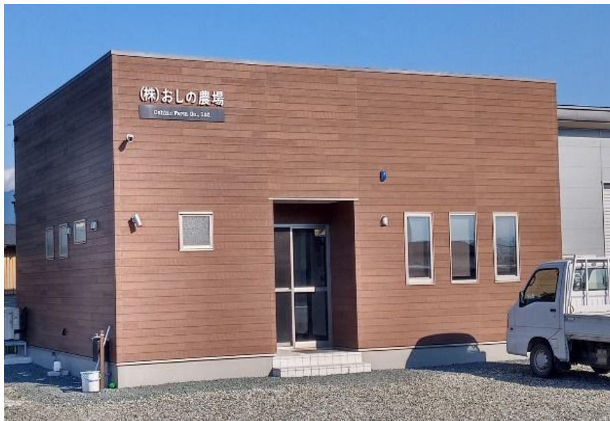
事務室兼作業準備室の外観
