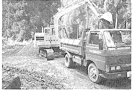
パワーショベルで作業道を作設
