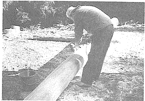
写真5 桁丸太の加工
