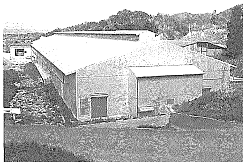
写真2 ウインドウレス成鶏舎（平成6年 新設）
