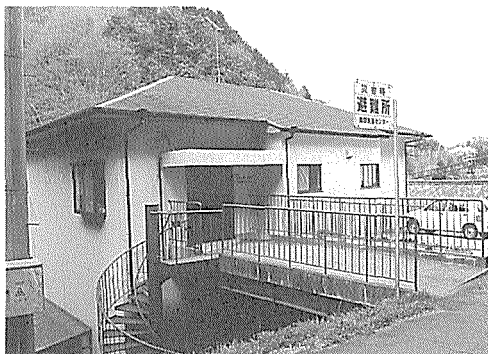
写真1 むらづくりの拠点となった南畑集落センター
