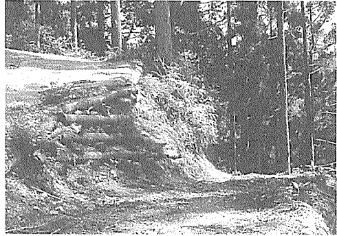
写真4 丸太組、舗装された作業道
