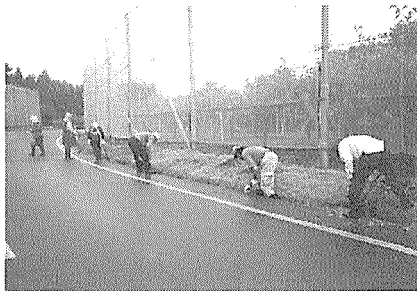
写真4 U字溝の清掃
