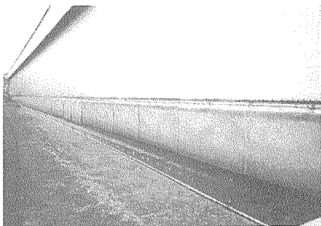
写真4 ウィンドウレス鶏舎側壁の自主開発のクーリングパッド下の管が散水用の水道管
