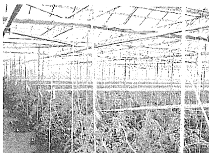
写真5 トマト株の上部に展開されたラノーテープ
