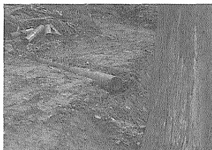
写真7・8 改良した金具を用いて横断排水工に用いた2本の丸太を固定
