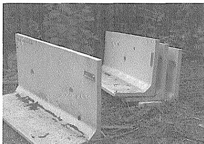
写真5 L型コンクリート擁壁
