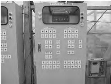
写真5 環境制御システム制御盤
