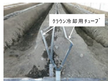
写真3 地下水を供給するための配管部
