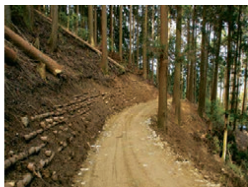
写真3 丸太組を使用した法面工
