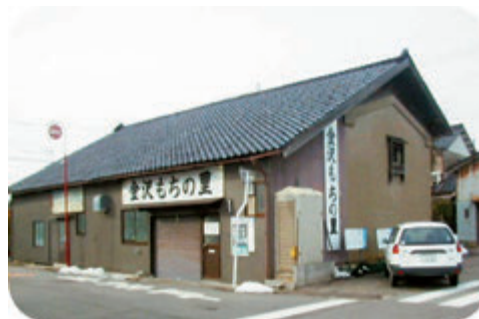
写真2 金沢もちの里製造拠点 (元J A金沢市の資材倉庫を改造)
