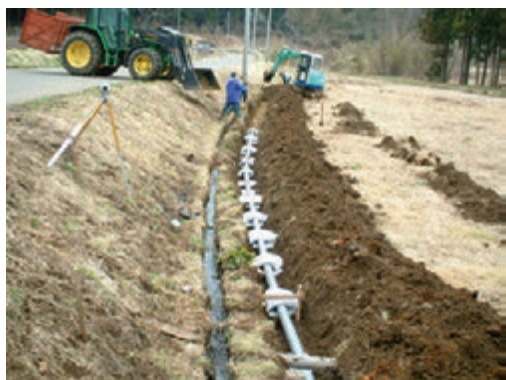
写真4 下水道工事の様子
