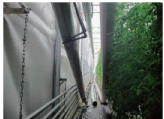
写真4 地震によって壊れた配管
