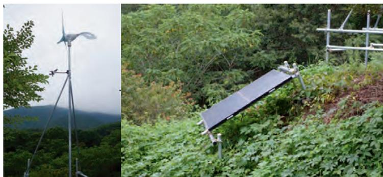
写真5 上記施設の電力は風力発電・太陽光発電でまかなわれている。
