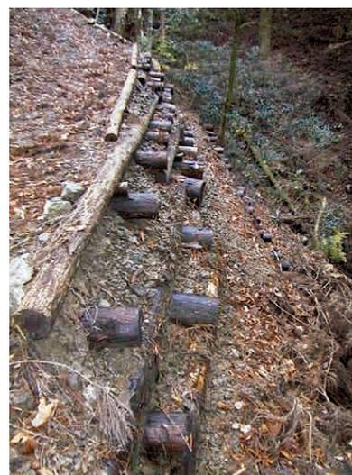
写真4 木組みをして開設した作業道
