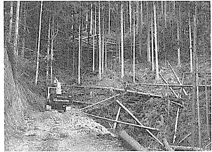
写真7 作業道開設工
