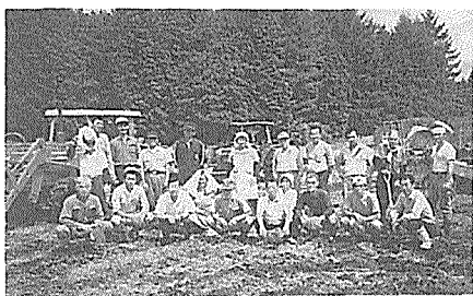
写真3 労力奉仕で敷地の造成作業
