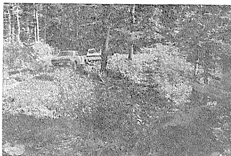
クローバーによる 林道法面の保全
