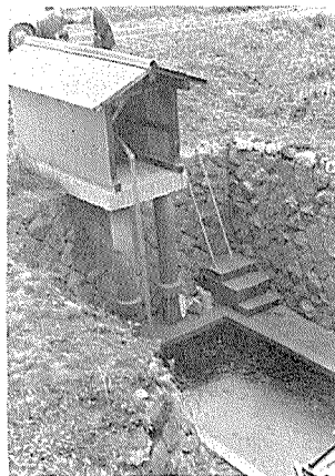
集水および揚水施設
