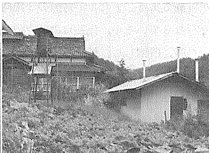
乾燥庫と燃料タンク
