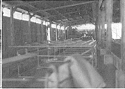
4～5 令用蚕室の内部
