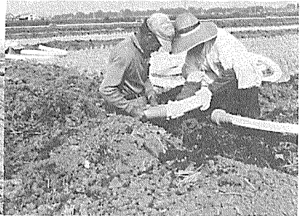
コルゲートパイプの埋設作業
