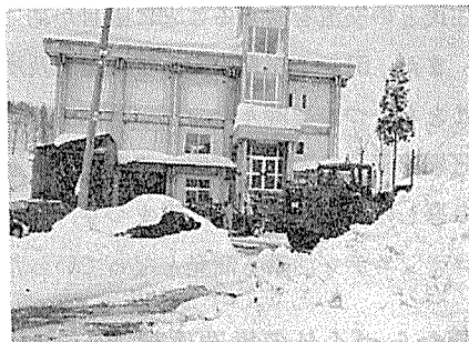
力を合せて建設した 克雪管理センター
