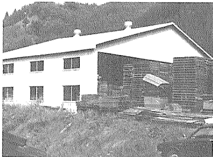
信栄林産（間伐材加工工場）
