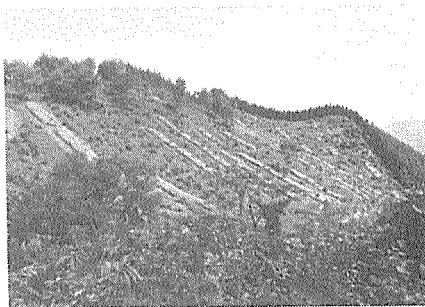
ほど木の伏込み状況 (大部分は野伏せ)
