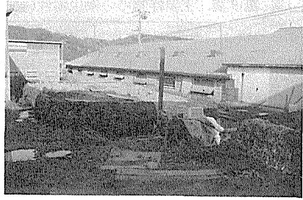
豚舎及びよく手入れ され完熟した堆肥
