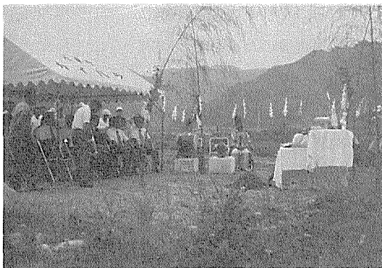
ほ場整備の起工式 (昭和53年)
