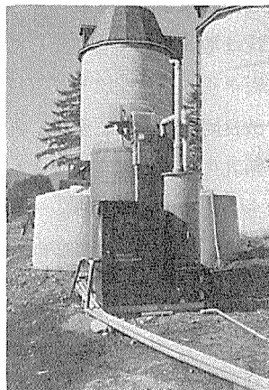
尿利用のための曝気施設
