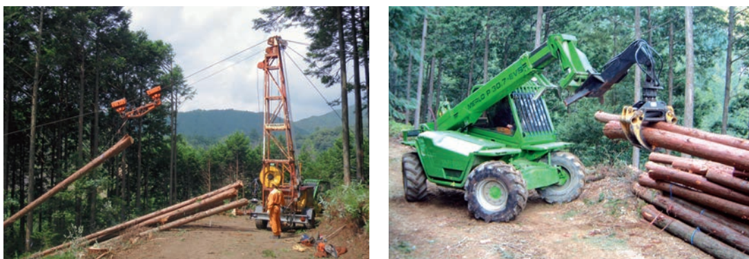
写真2 タワーヤードとスキディングローダー
