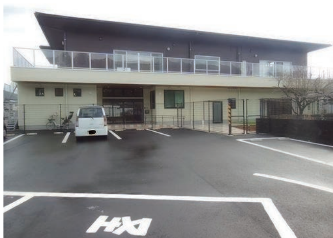
写真7 2017年末に完成した保育園の新園舎外観
