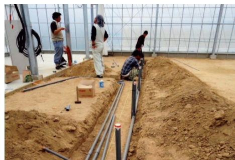
写真5 配管の自己施工
