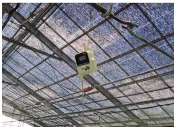
写真16 データロガーの設置状況
