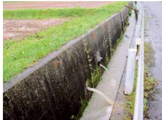
写真2 暗渠排水の噴出
