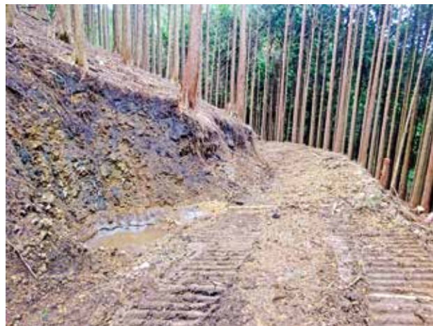
写真5 緩勾配・谷高カント・浸透柵による防災水源涵養路網
