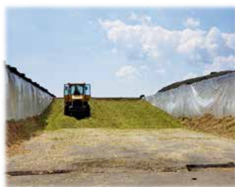
写真2 大型バンカーサイロ
