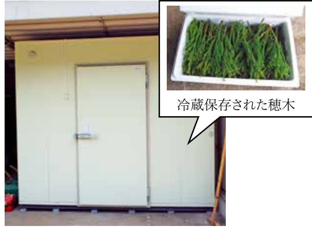
写真10 冷蔵保存用の冷蔵施設
