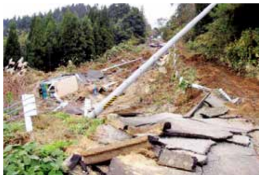
写真2 震災による被害
