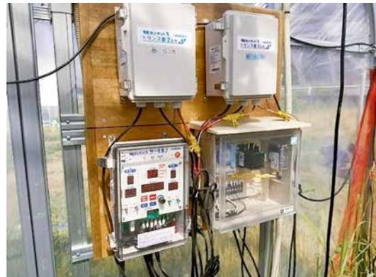
写真9 省力化に向けた施設内環境の自動制御装置
