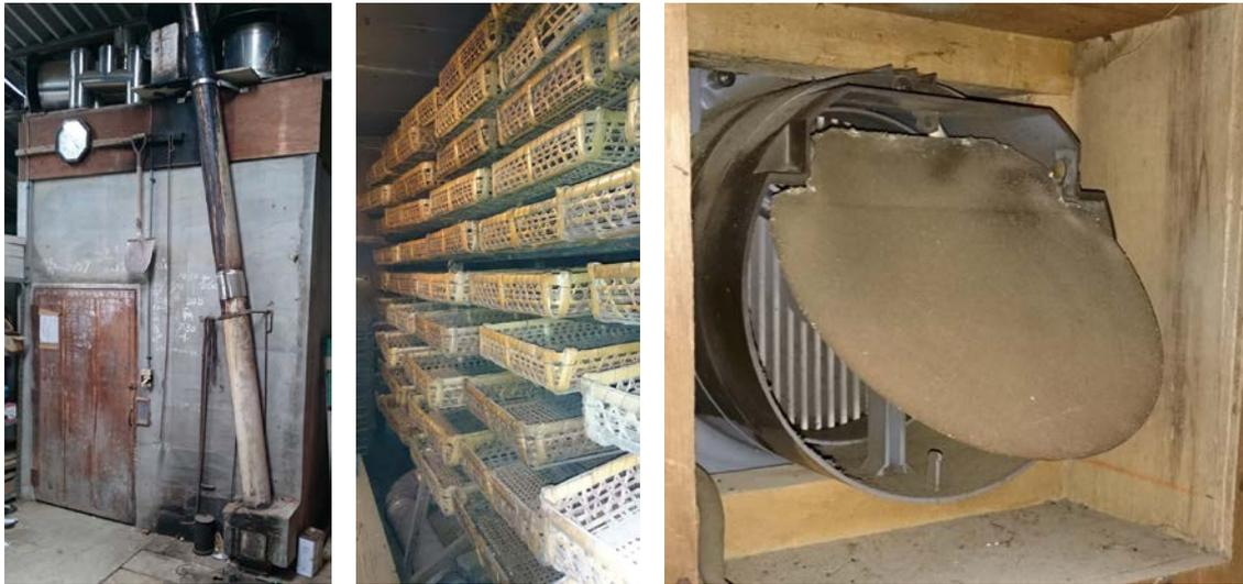
写真10 薪乾燥室 乾燥容量が大きく、換気扇により乾燥効率が向上
