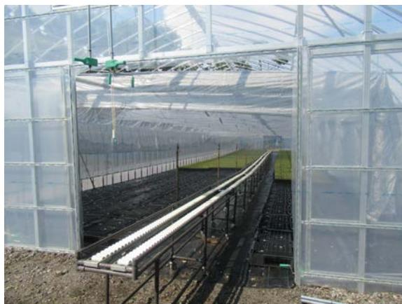
写真8 ハウス内における移動式レール台車
